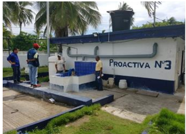
Punto de descargas de carro tanque séptico Estación de bombeo No.3
