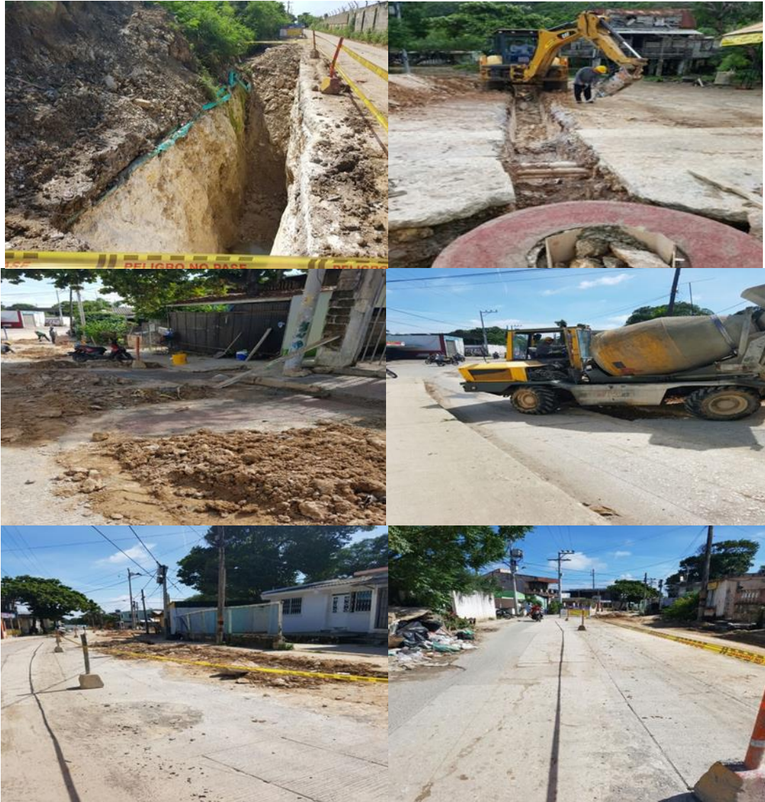
Construcción e instalación redes de alcantarillado
