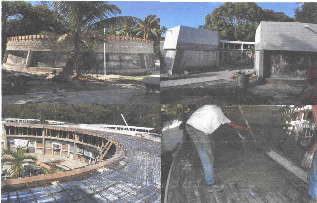
Ampliación de módulos, Interventoría, 2015
