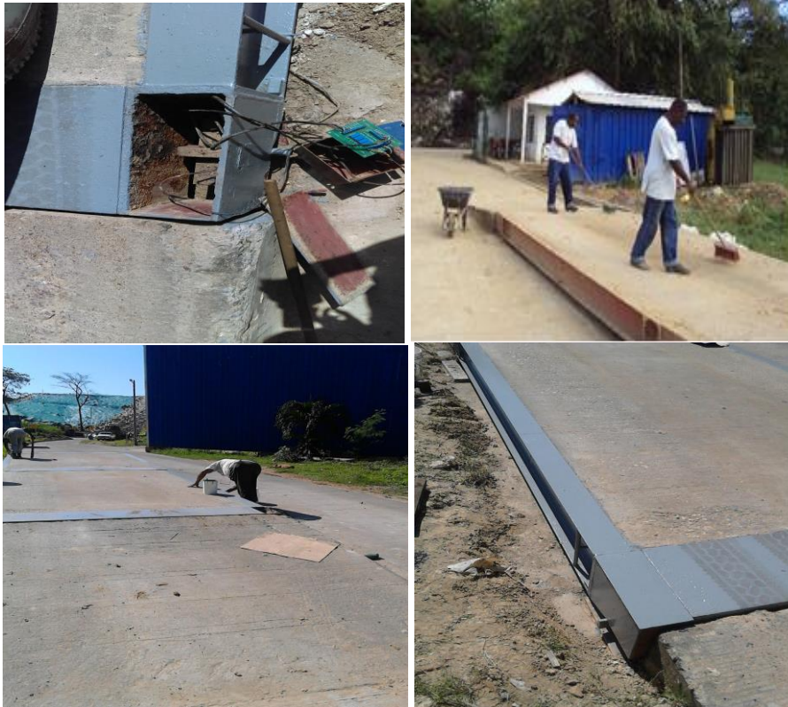
Pintura de estructura metálica del equipo de pesaje
