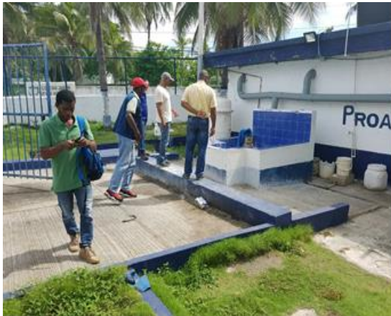
Punto de descargas de carro tanque séptico Estación de bombeo No.3
