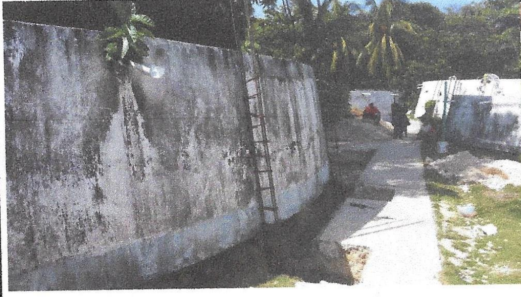
Condiciones antes de intervención, 2014
