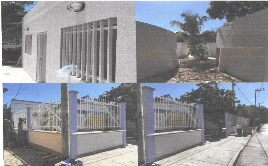
Construcción morgue y cerramiento, 2015
