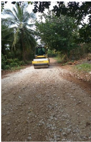
Mantenimiento Vía Bowie Bay
