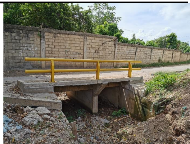
BOX COULVERT LA PAZ
