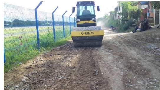
Mantenimiento Vía Clay Mount
